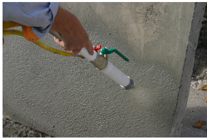
Bild 3: Putzmeister-Strobl-Luftstromdüse Fig 3: Putzmeister-Strobl-air injector
