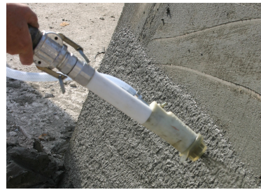
Bild 4: Einfache Putzerdüse Fig 4: simple fettle gun
