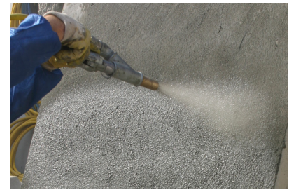
Bild 5: PAGEL-MAWO-Düse Fig 5: PAGEL-MAWO-injector
