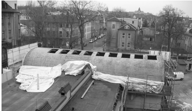
Bild 5: textilverstärkte Tonnenschale Figure 5: textile strengthened barrel vault
