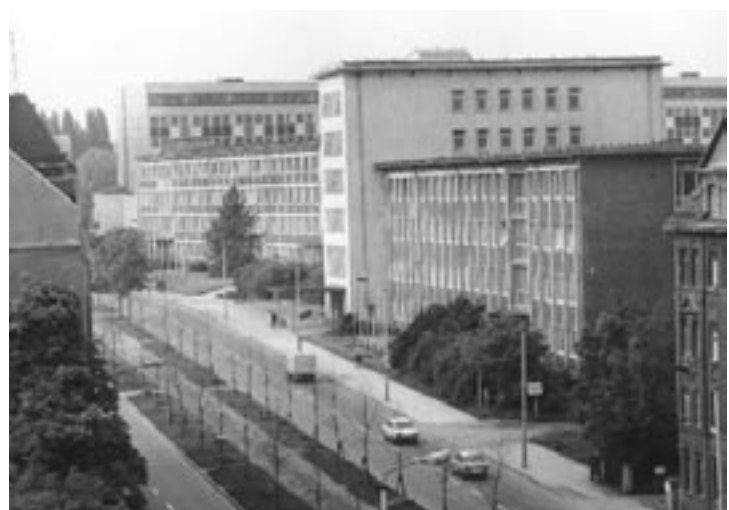
Komplex an der Reichenhainer Str. 70, 1987
