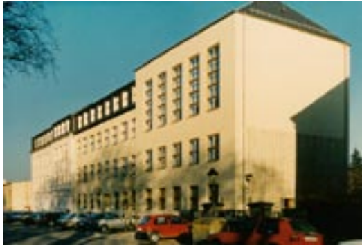
Saniertes Gebäude der Philosophischen Fakultät in der Wilhelm-Raabe-Straße 1994
