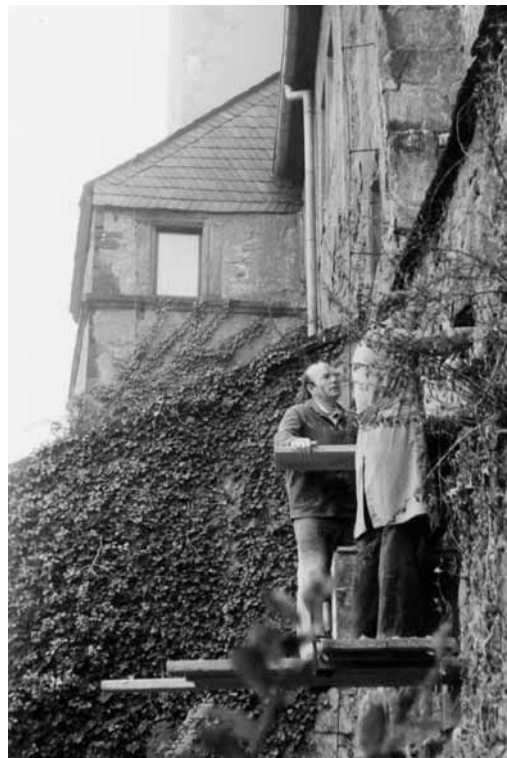
Abb. 4 Rochlitz, Schloss, Behelfs-Reparaturarbeiten am Südflügel, links Museumsleiter Udo Baumbach, 1976
